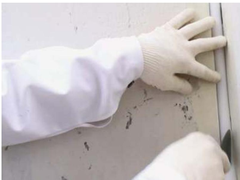
Жгут, устанавливаемый в стыке, должен быть обжат на 20-50% от своего первоначального диаметра.
